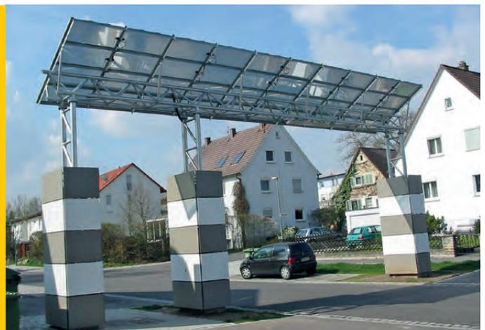
Die fertiggestellte Photovoltaikanlage »Solares Stadttor« ist nicht nur ein optisch reizvolles Anschauungsobjekt, sondern stellt auch ein passendes Objekt zur Akzentuierung des Aldinger Ortseingangs dar. Die leichte Stahlkonstruktion ist neben der Tragefunktion für die Photovoltaikanlage Werbeträger für die Aldinger Gewerbetreibenden. Die 60 x 80 und 60 x 1,30 cm großen Tafeln können gepachtet werden.
