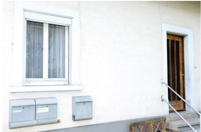
Ganzheitlich sanieren: Wird die Fassade erneuert, ...
