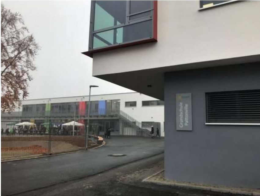
Abbildung 18: Grundschule Pattonville; Quelle: www.remseck.freiewaehler.de
